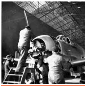
Montage de l'hélice sur le moteur en fin de chaîne d'assemblage.
