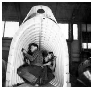
Rivetage du revêtement sur la structure du fuselage arrière.
