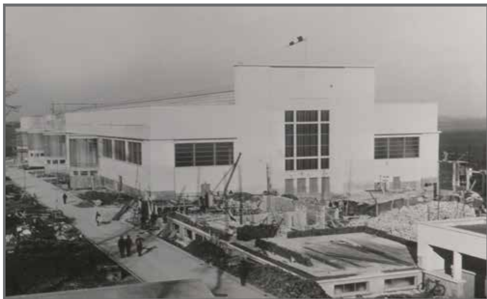
L'usine de Châteauroux-Déols en construction.
