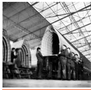
Déplacement par portage du fuselage arrière jusqu'au bâtiment D.
