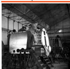
Assemblage de la partie avant du fuselage (cabine pilote et cloison moteur).
